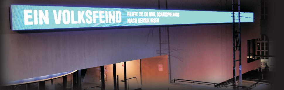
Theater Basel: 23,5 x 1m Fassaden-Videodisplay mit SMD 3in1 Outdoor Leds, frontseitig wartbar
